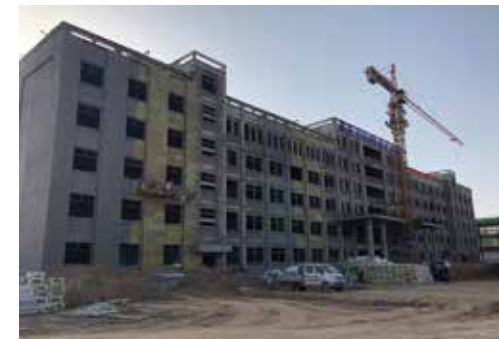
正在建设中的石化中学
