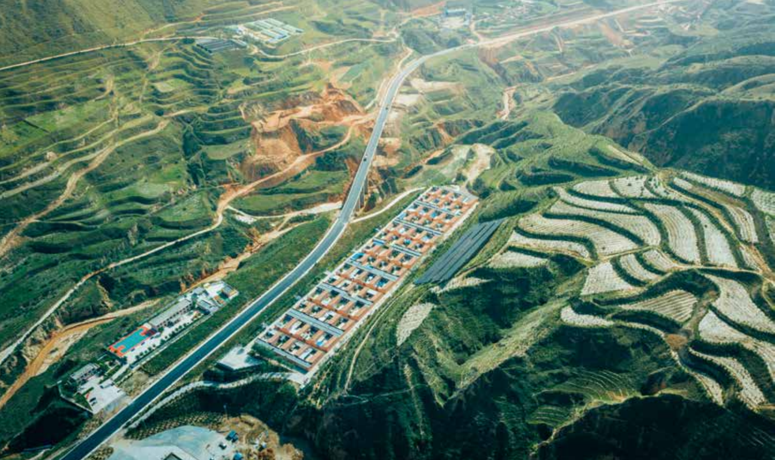
蜿蜒平整的布楞沟村通村硬化路与折红二级公路连接了起来，通向外面的世界
