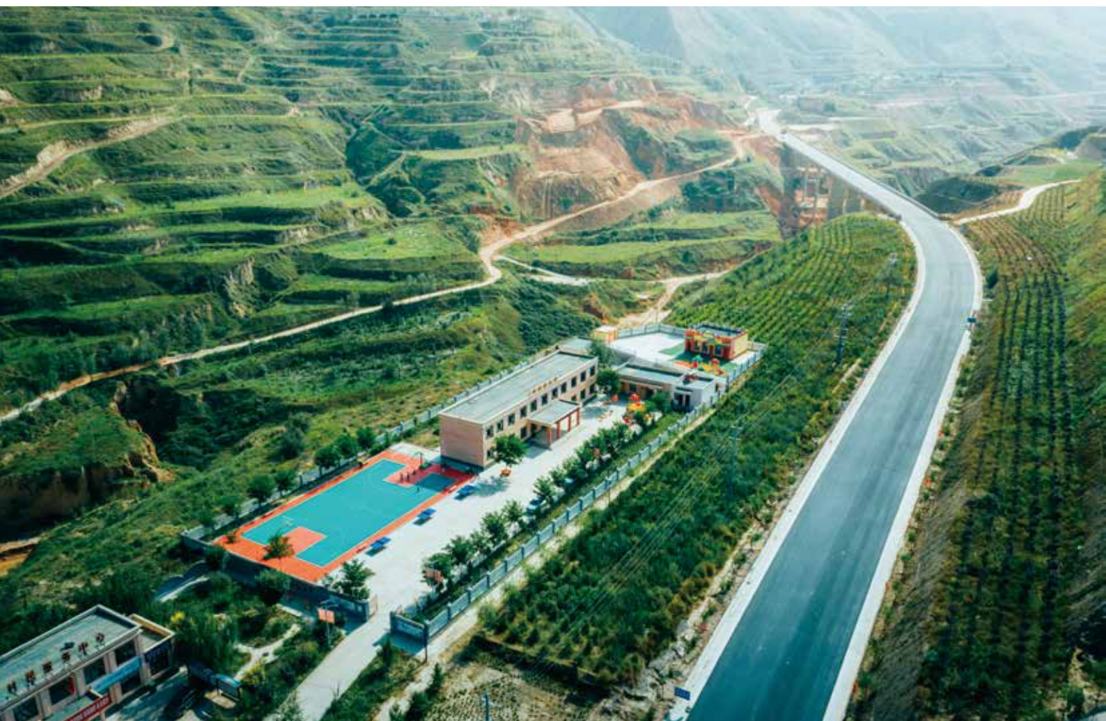
援建后的布楞沟村小学全貌
