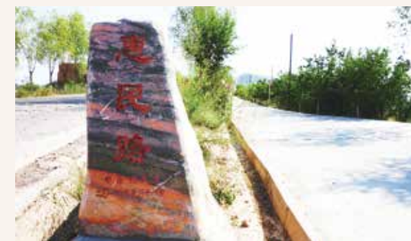
援建后的布楞沟村通村硬化路
