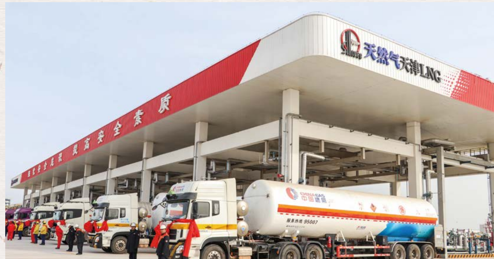
▲ 2018 年 2 月，第一辆液化天然气车驶出天津 LNG 接收站，标志着国内国产化程度最高的 LNG 接收站投产成功
