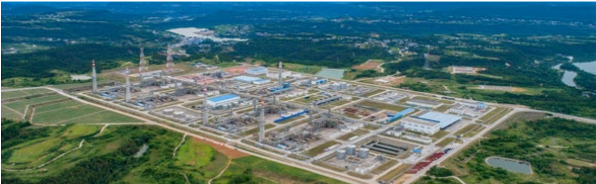
在元坝气田，公司建设了国内首座具有自主知识产权的大型天然气净化厂
