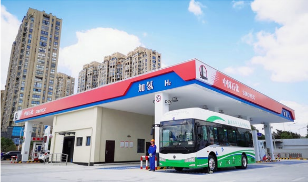
中国石化浙江嘉兴嘉善善通加油加氢站
