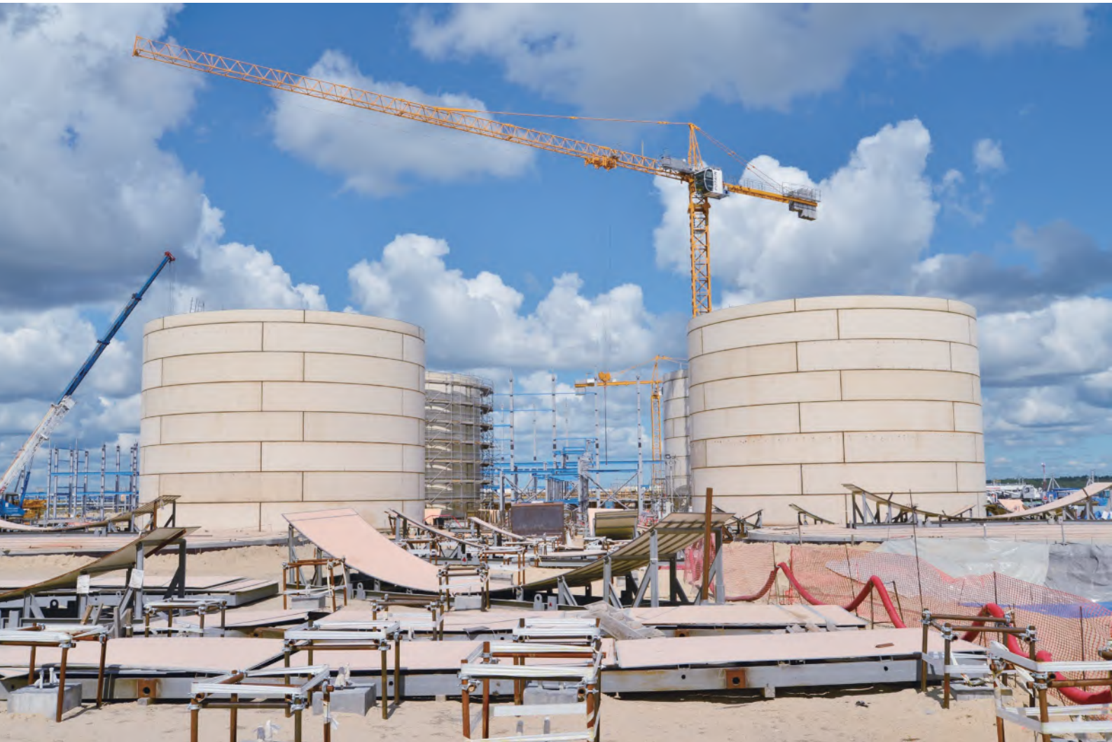
中国石化炼化工程宁波工程公司俄罗斯AGPP项目现场
