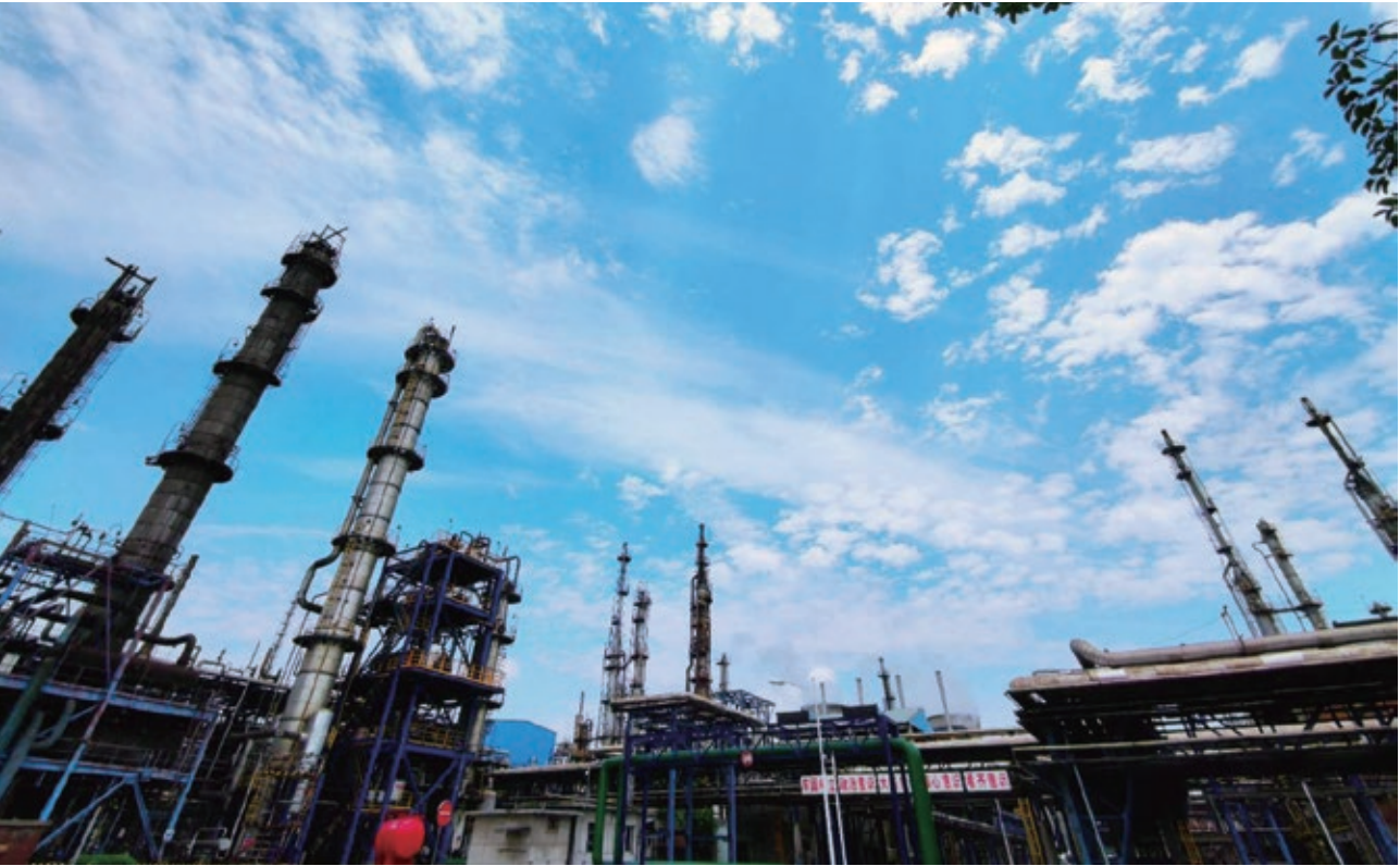
中国石化重庆川维公司建设5万吨/年高浓度甲醇废水环保处理装置、3.5万吨/年废硫酸再生循环利用装置、炭黑干化综合利用装置，将危险废物资源化利用，年回收甲醇2.6万吨、硫酸3万吨，炭黑滤饼产生量由4万吨/年降低至1万吨/年，并可作为燃料回收利用，危险废物综合利用率达到98.9%
