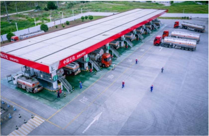
中国石化江苏石油对油库、码头油气回收装置进行扩容升级改造，并通过强化油品装卸、储存、运输全环节密闭管理，提升油气回收率1.09%，每年回收8,500吨汽油，实现生态和经济效益双赢
