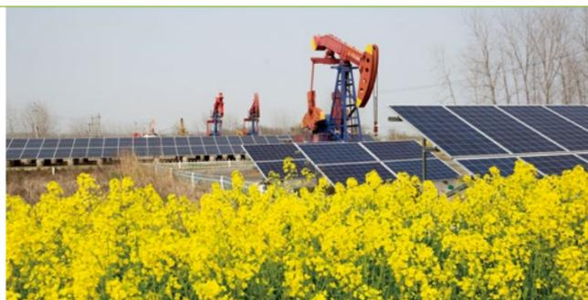
④ 江苏油田采油二厂使用太阳能光伏发电为抽油机供电
