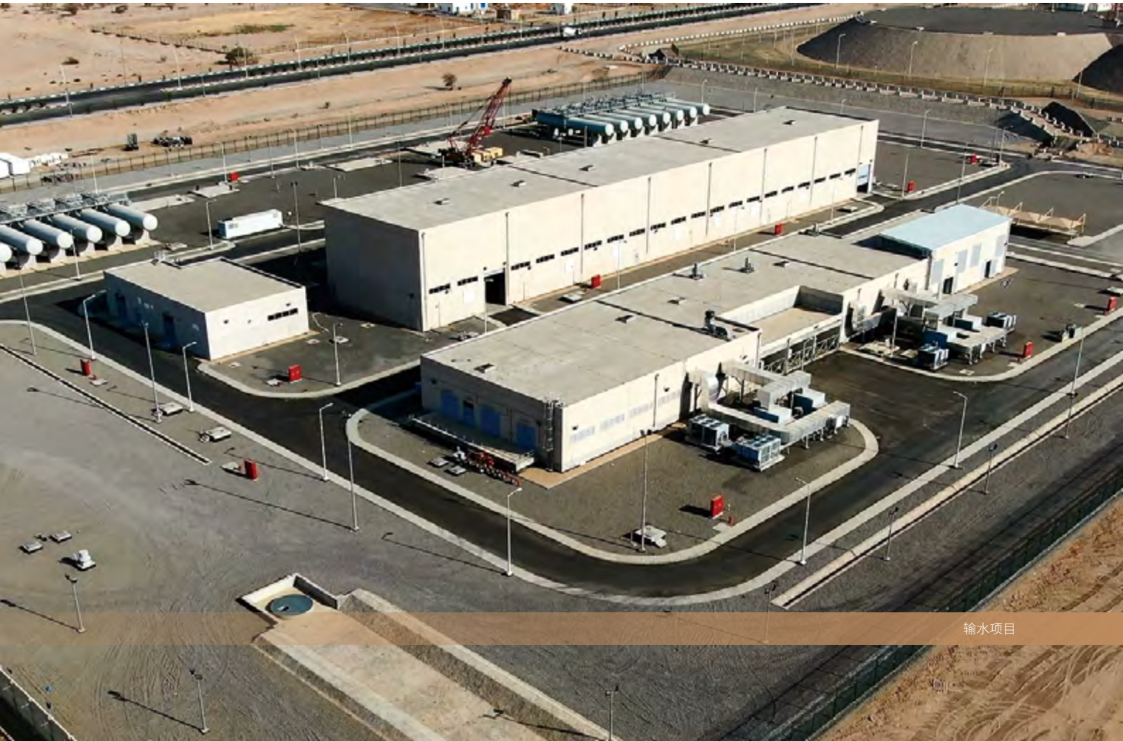
中国石化石油工程公司承建的沙特海米斯阿哈德桥项目
